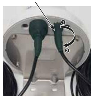
**6** Kencangkan kabel pada tiang menggunakan cable-ties.
